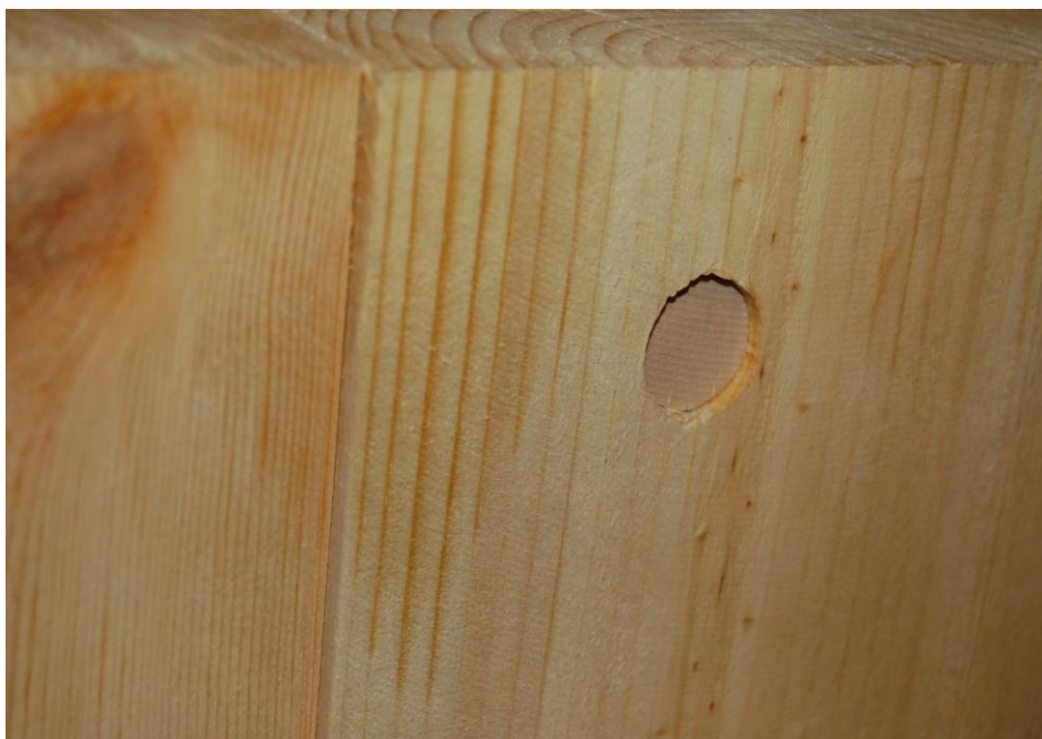
Bilde 8. Dyblene har løsnet enkelte steder. Dette resulterer i omkant mellom bord.
