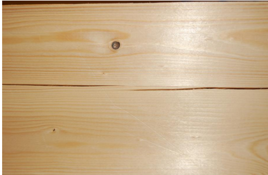
Figur 2. Sprekk innad i bord der lim søles mellom bord.
