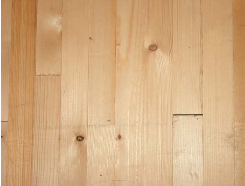
Bilde 2. Buttskjøter i et massivtreelement
