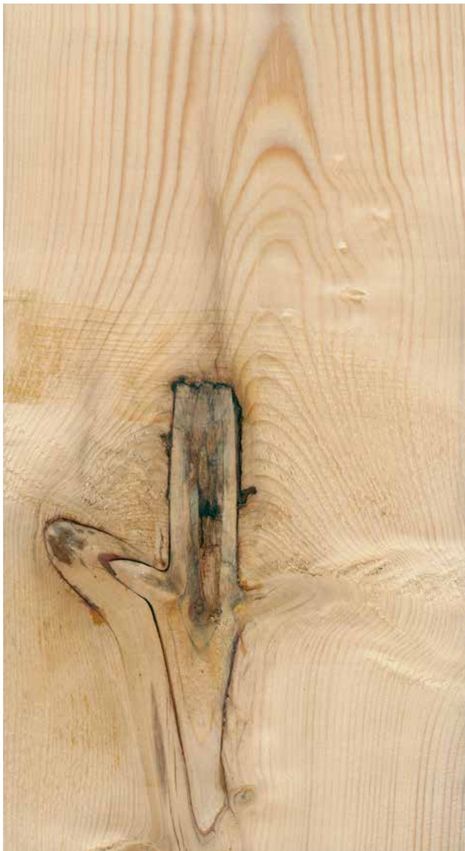
Figur 53. Råte i et toppbrudd, planken vrakes.
