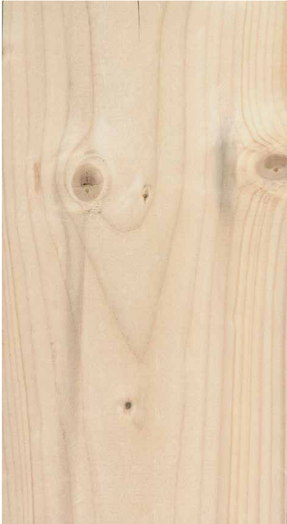
Figur 11. Bildet viser utsiden av planken. Planken nedklasses til C18 på grunn av brent med mindre brent-området er gjennomgående, da må planken vrakes.
