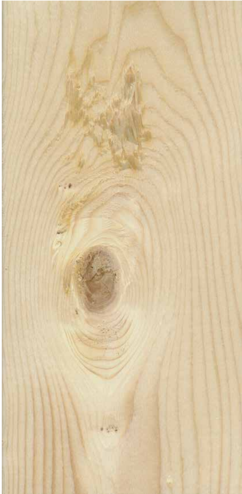
Figur 79. Høvlingsutslag på oversiden av kvisten. Ingen nedklassing av denne planken.
