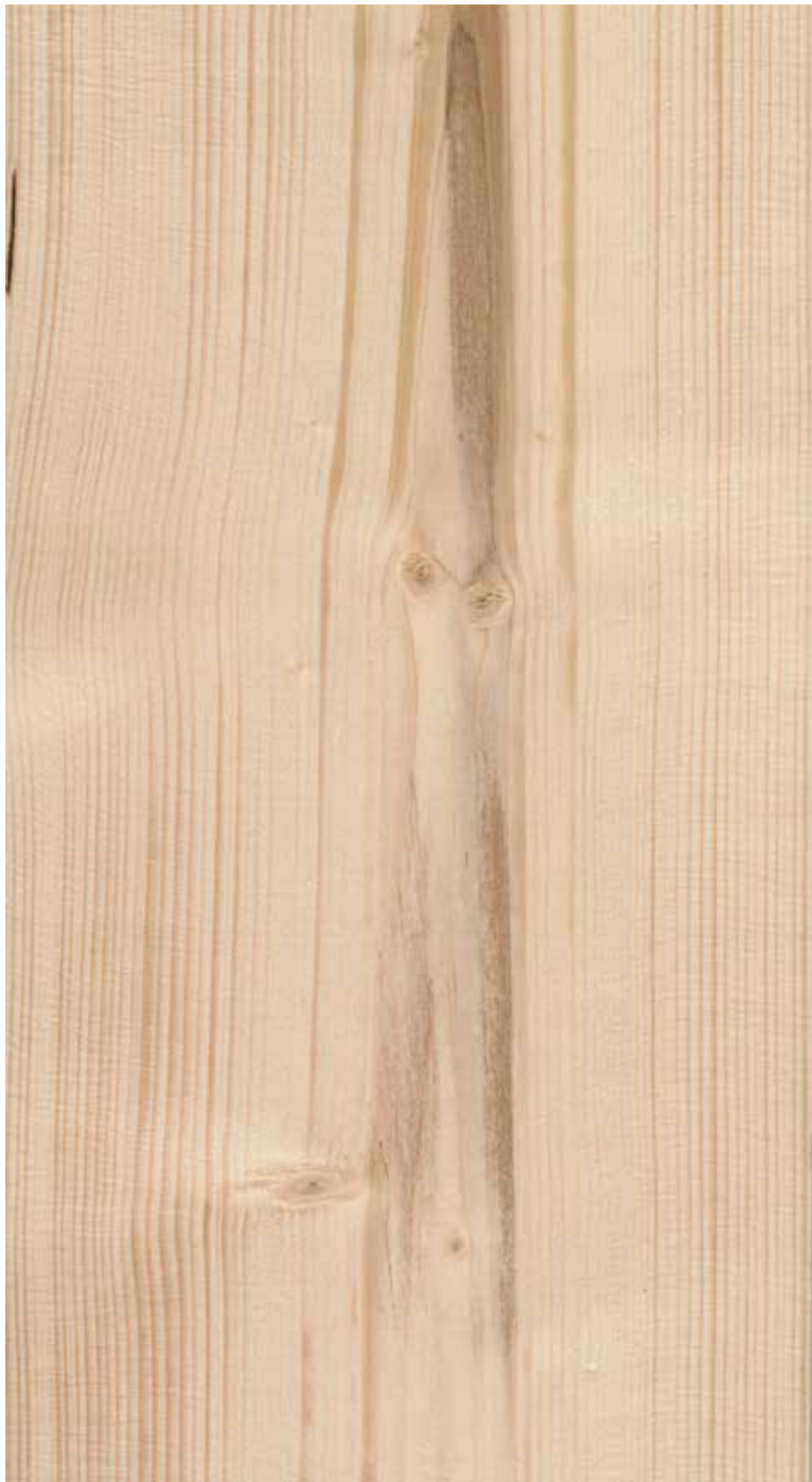
Figur 19. Råte, planken vrakes.
