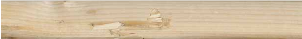
Figur 75. Skade på kant sannsynligvis etter truck. Planken vrakes.
