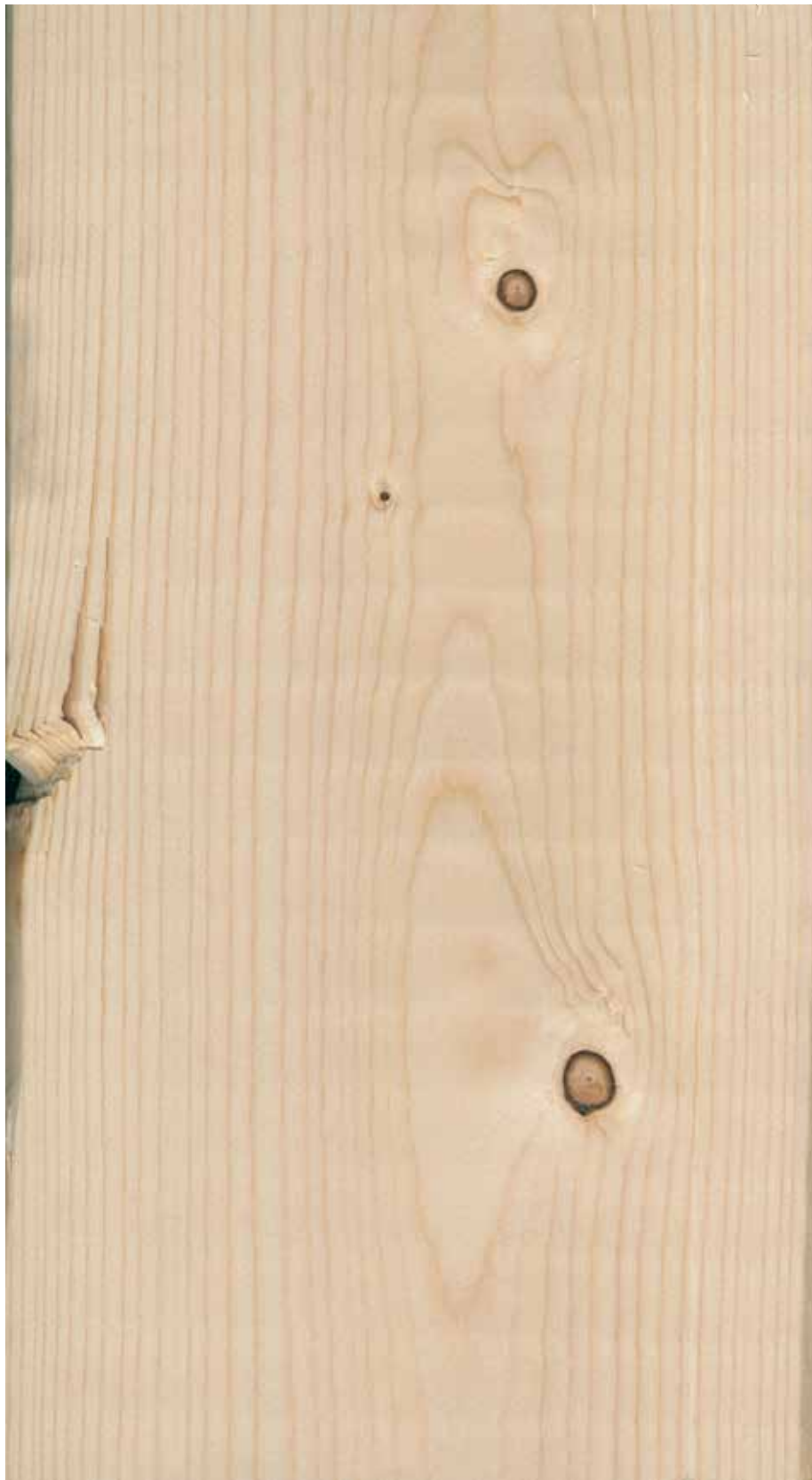
Figur 71. Kraftig skade. Planken vrakes.
