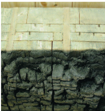
Brannpåvirket tre med forkullingslag.
