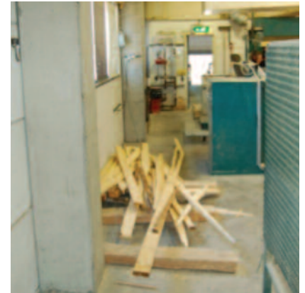
Denne rømningsveien er ikke sikker. Hvis det er mørkt i rommet og man går etter nødutgangsskiltet, kommer man ikke frem.
