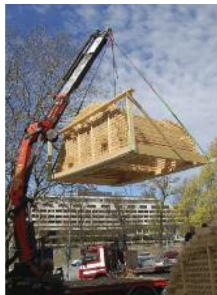
De to halvdelene av konstruksjonen ble transportert med lastebil og deretter sammenføyd på tomten ved museet. Foto: Ingelin Bakken
