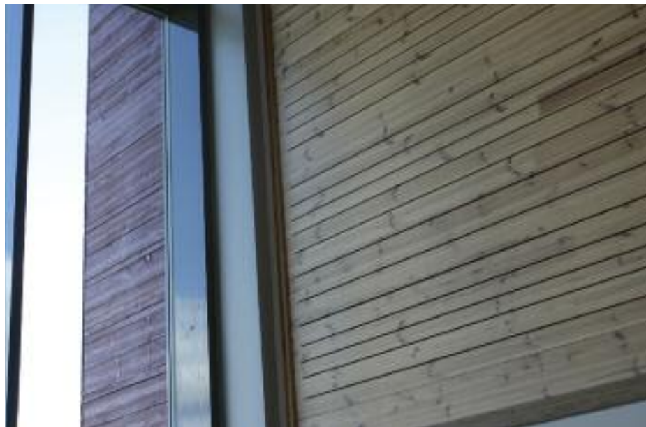
Innfreste spor i massivtreelementene for å bedre akustikken.
