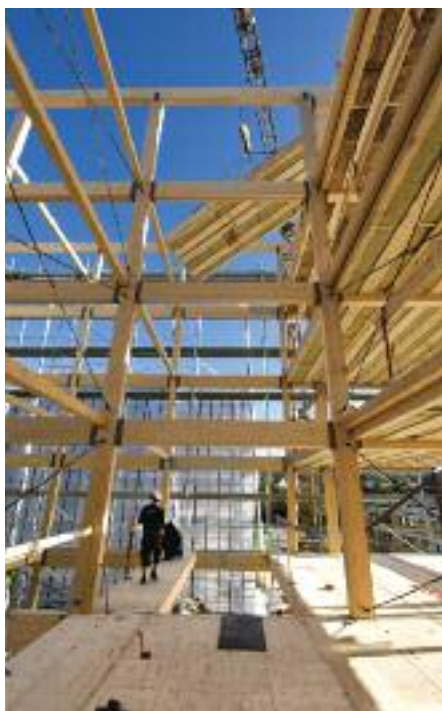
De ferdig isolerte bjelkelagkassetene skrues fast. Foto: Sören Håkanlind.
