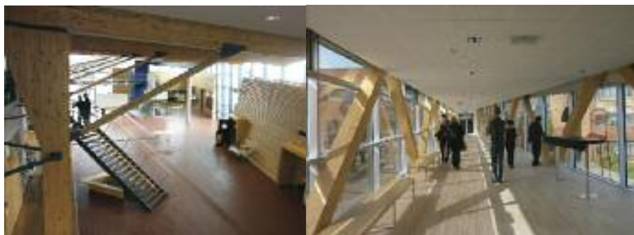
Linnaeus Universitet. I bygg M og N er det utstrakt bruk av tre, både i interiøret og som bærende konstruksjon. I vrirlehall i bygg M gir bærekonstruksjonen i taket mot den åpne vindusfasaden et unik uttrykk.
