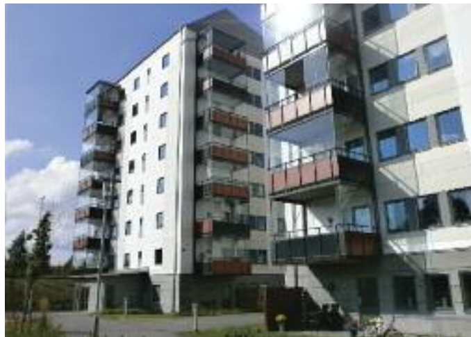
Portvakt, er det nyeste byggeprosjektet i Välle Broar. Portvakt består av 2 bygg, begge i 8 etasjer. Bærekonstruksjonen består av massivtrelementer. Veggskivene i massivtre har en tykkelse på 83 mm. For avstivning av bygget er det lagt inn totalt ca. 30 strekkstag som går vertikalt gjennom bygget. Totalt har veggene en tykkelse på 538 mm, som gir en U-verdi på 0,10. Lufttethetsmålinger viser at bygget klarer < 0,2 \text{ l/sm}^2 . Beregnet energiforbruk er 50 \text{ kWh/m}^2 , med følgende fordeling: Varme 15 \text{ kWh/m}^2 , varmtvann 25 \text{ kWh/m}^2 , bygningselektrisk 10 \text{ kWh/m}^2 .
