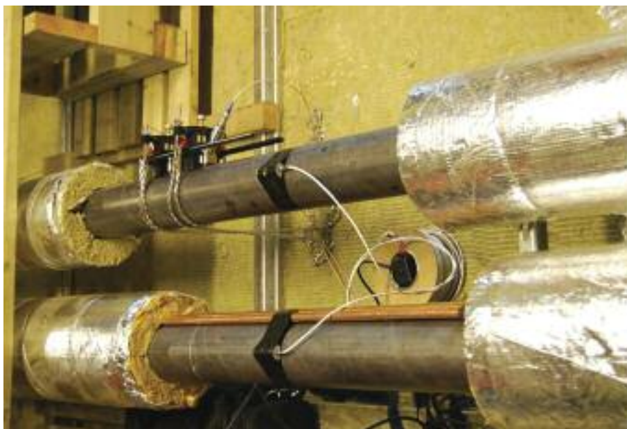
Varmeeffektmåling på vv-rør.
