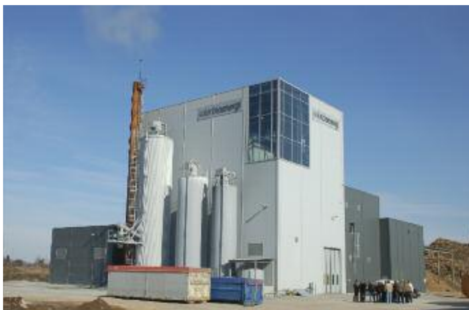
Solor Bioenergi forvandler impregnert trevirke til varme og elektrisitet. Dette gir flere ganger mer energi enn det som kreves i produksjonen av trelast, og er derfor en stor miljøfordel.
