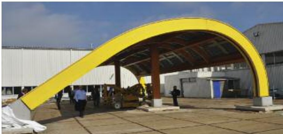
Ladestasjon for elbil med solcellepanel på taket. Demomodellen satt opp og bedriften har 200 i ordre!
