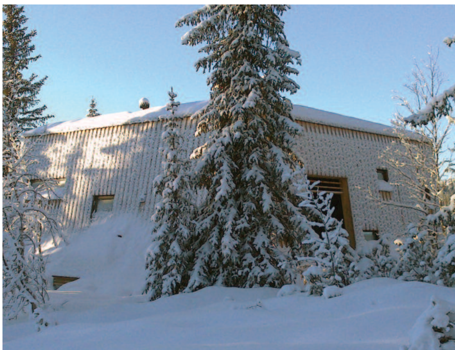
Hytte Kosekroken, fasade. (Foto Norsk Massivtre)
