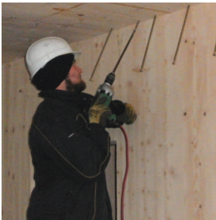
Skruing av massivtreelementer (Foto Treteknisk)
