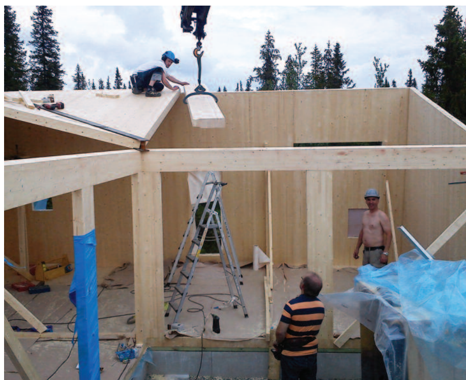
Hytte Kosekroken, elementmontasje. (Foto Norsk Massivtre)
