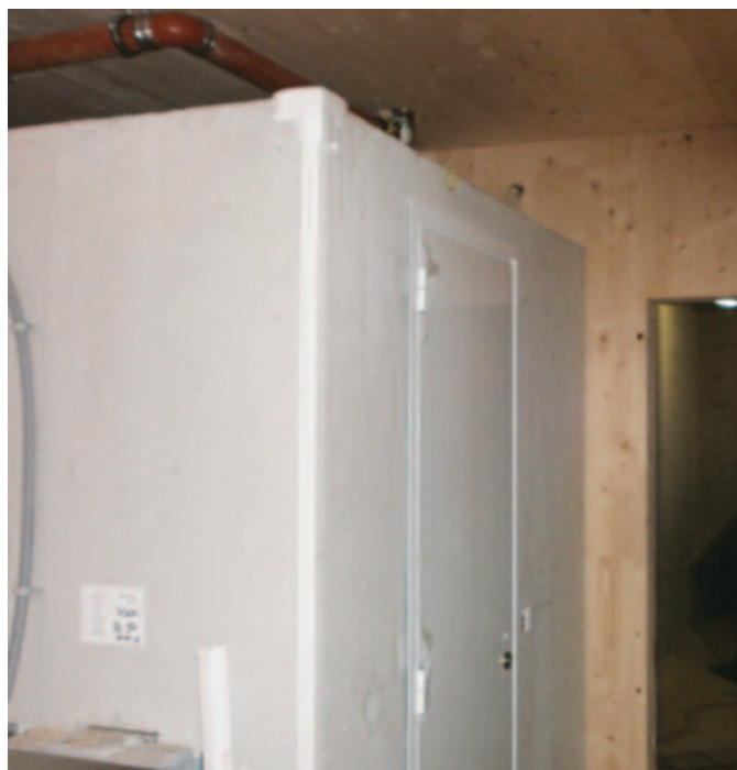
Vegger og dekker i massivtreelementer, til venstre en prefabrikeret baderomsmodul. (Foto Treteknisk)
