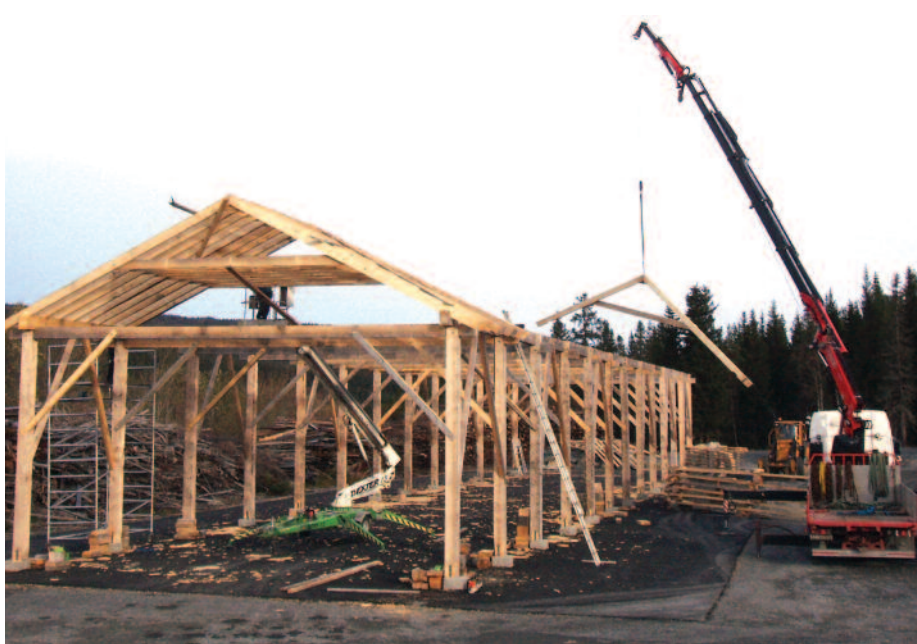
Alle grinder er heist på plass. Takstolene monteres med kran. Det er skåret hakk i stavleggerne som passer for sperrene.
