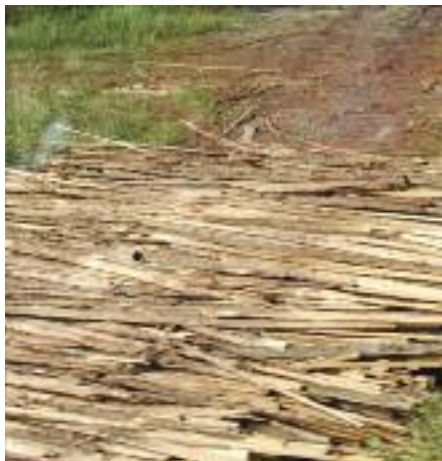
Eksempel på bakhun brukt som dekke for tømmertransport ved St. Petersburg.
