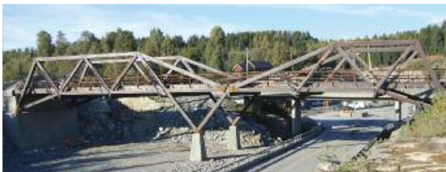
Sletta bru ved Eidsvold over E6. (foto: E. Aasheim)
