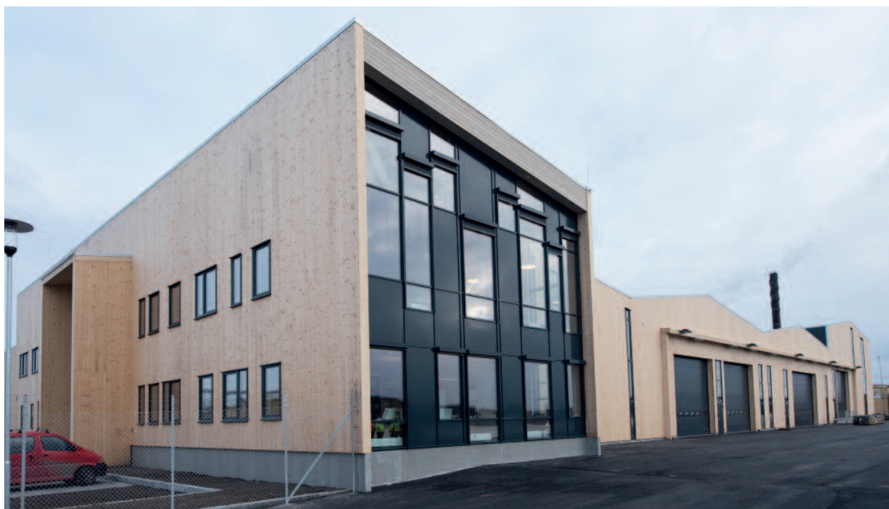
Borg havn. Kontor- og lagerbygninger i massivtre.
