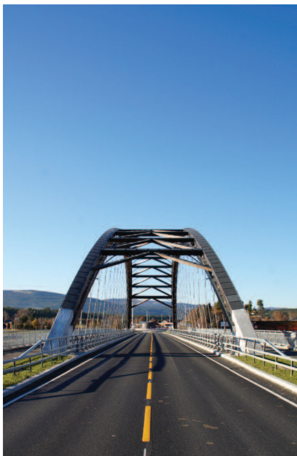
C 40-virke i limtrebuene i Steibrua på Alvdal.
