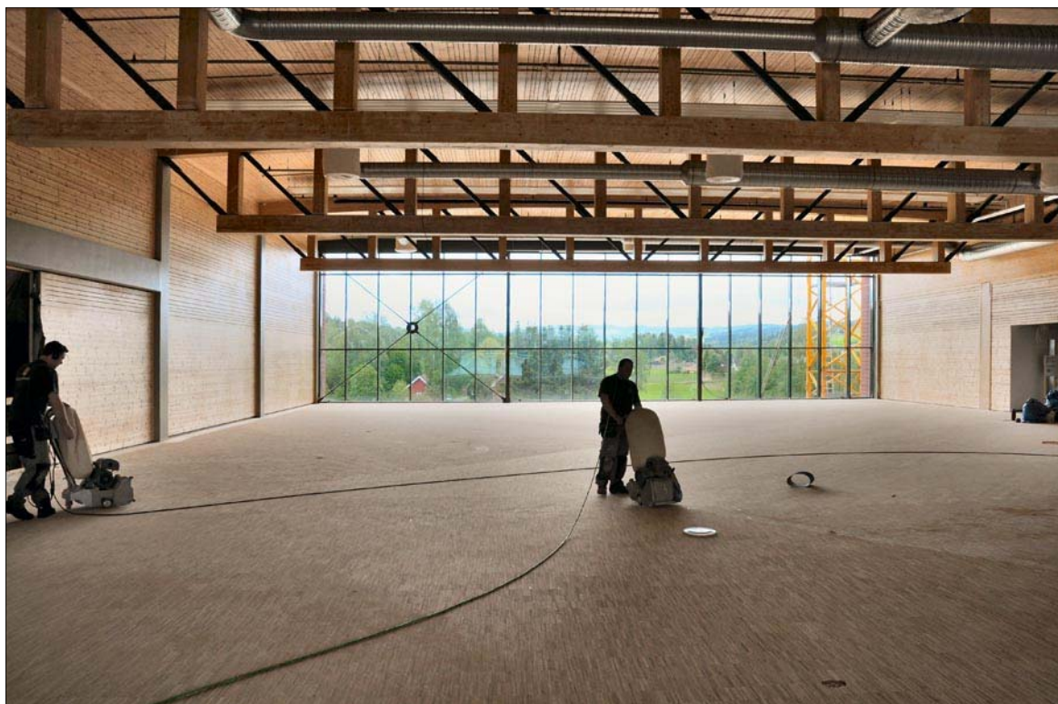
Figur 1. Biblioteket i nye Hadeland videregående skole under bygging med akustikkelementer med slisser i øvre del av vegg og i himling.
