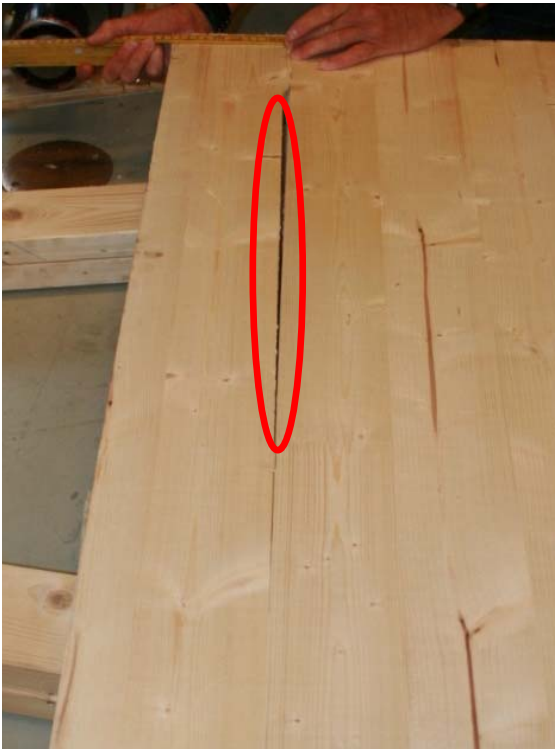
Figur 16. Prøve nr. 1: Åpning i limfuge (ca. 50 % av lengden) mellom to ytterlameller medførte skjærbrudd i dette sjiktet. Dette skyldes en produksjonsfeil.
