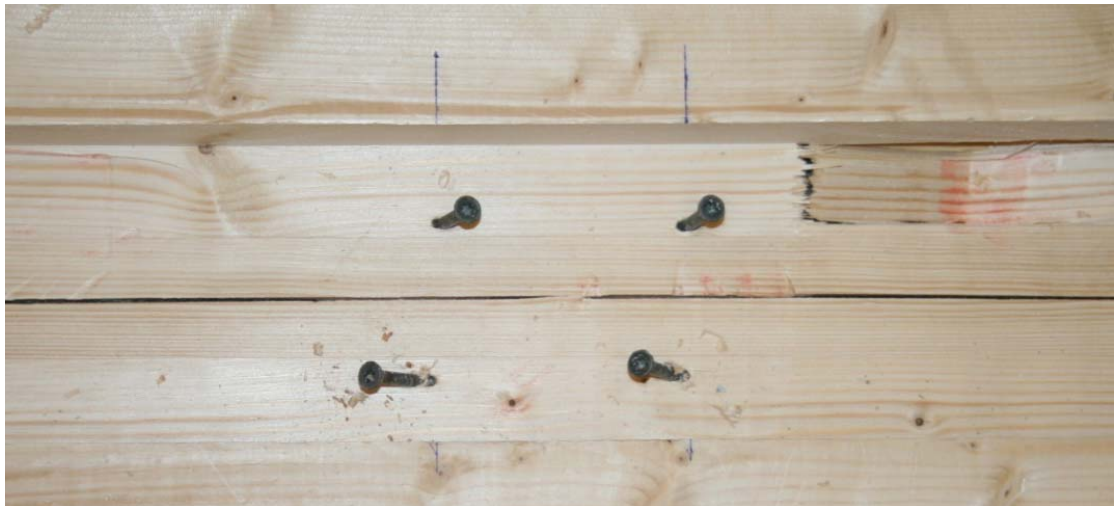
Figur 30. Prøve nr. 6: Skjøtebord fjernet etter at element er kjørt til brudd. Skruene har blitt belastet til flytning.
