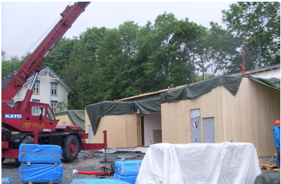
Figur 84. Hele elementer heises på plass og sikrer en rask og effektiv montering, men det er likevel viktig med tildekking hvis det er nedbør.
