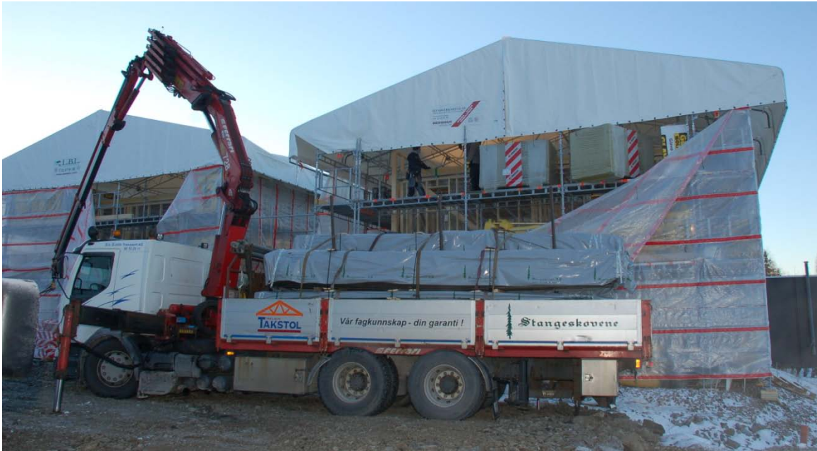
Figur 86. For å sikre de plassbygde konstruksjonene mot fukt under byggeperioden, ble det bygget under telt.
