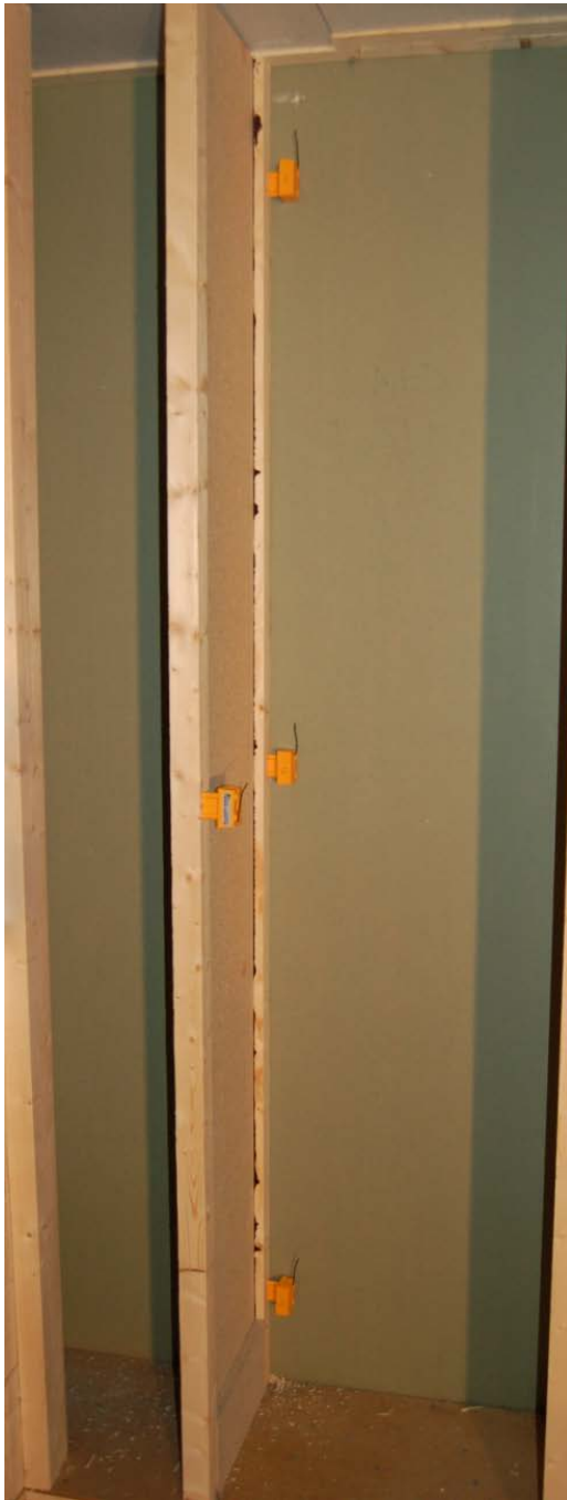
Figur 61. Loggere montert inne i veggen.
