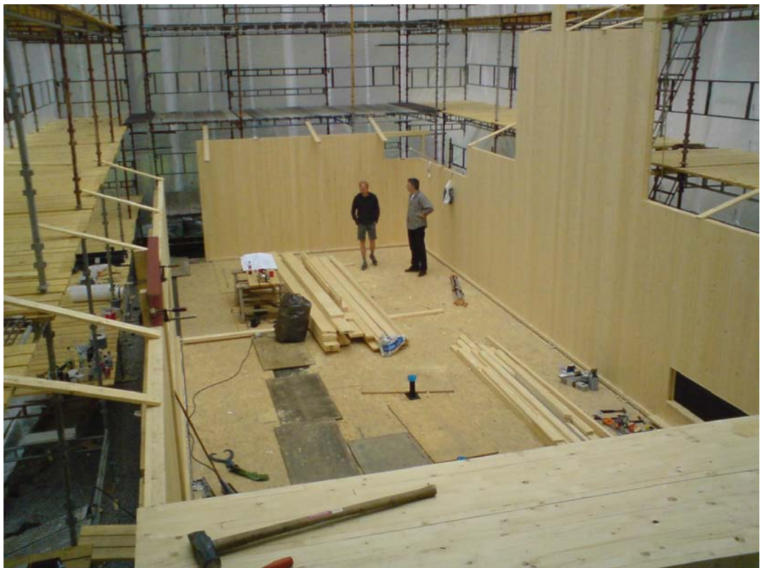
Figur 83. Her er det benyttet et bæresystem i massivtre. Foto: Stein Stoknes.
