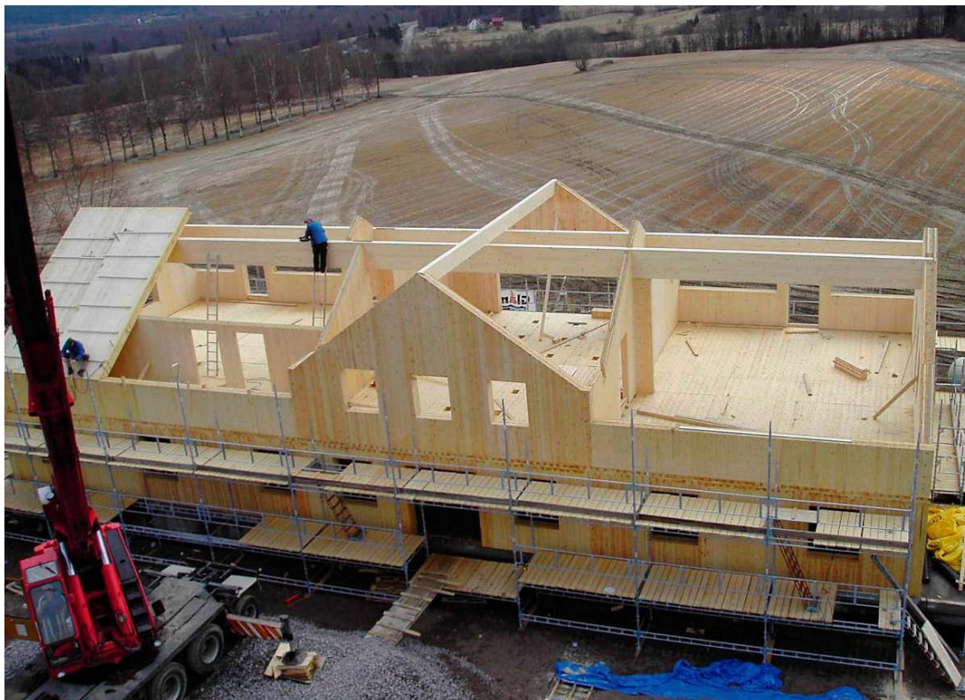
Figur 5. Elementbygg: Bygging ved bruk av elementer.
