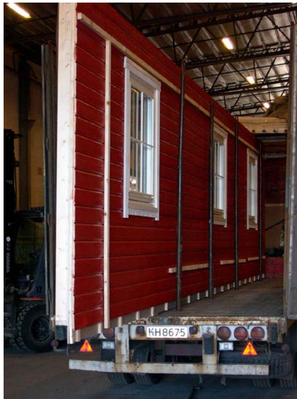
Figur 4. Elementbygg: Prefabrikkert yttervegg klar for transport til byggeplass.
