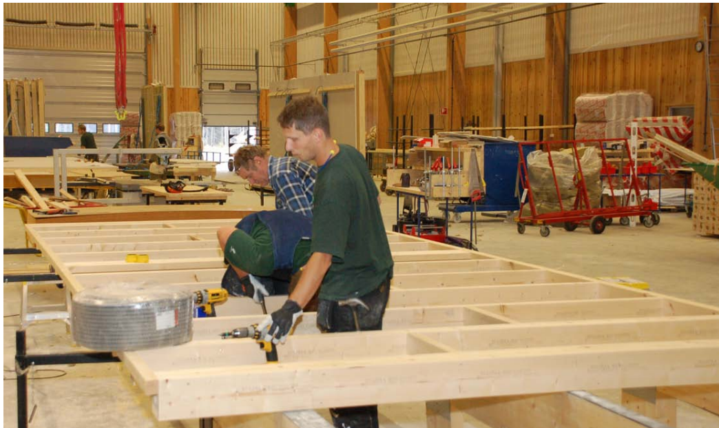
Figur 3. Elementbygg: Produksjon av veggelementer i fabrikk.
