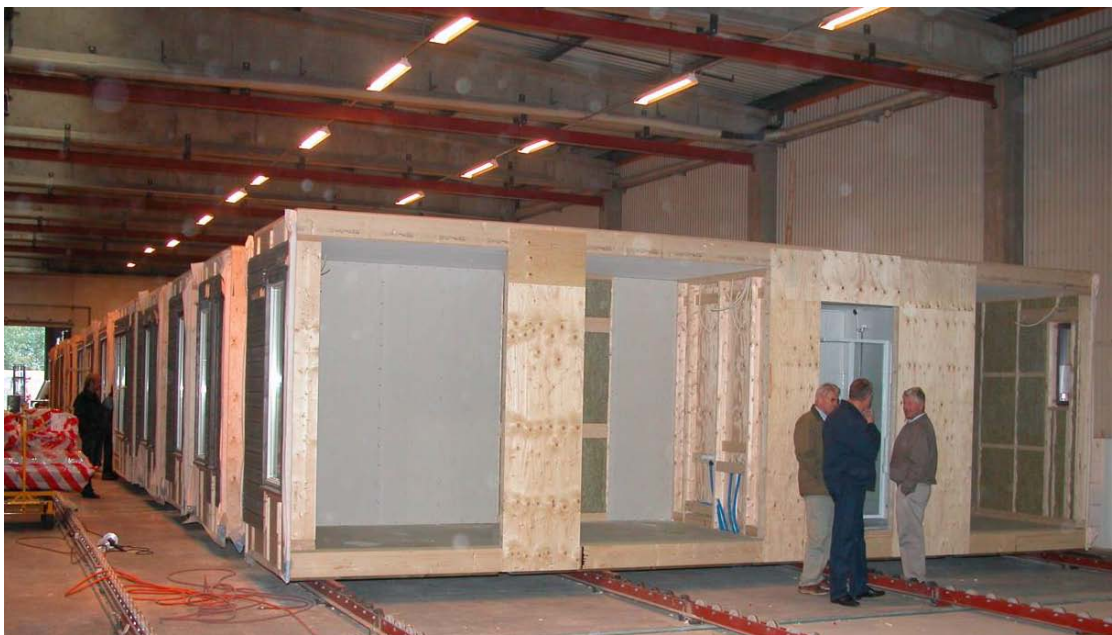
Figur 7. Volumseksjoner: Prefabrikkering av volumseksjoner i fabrikk.
