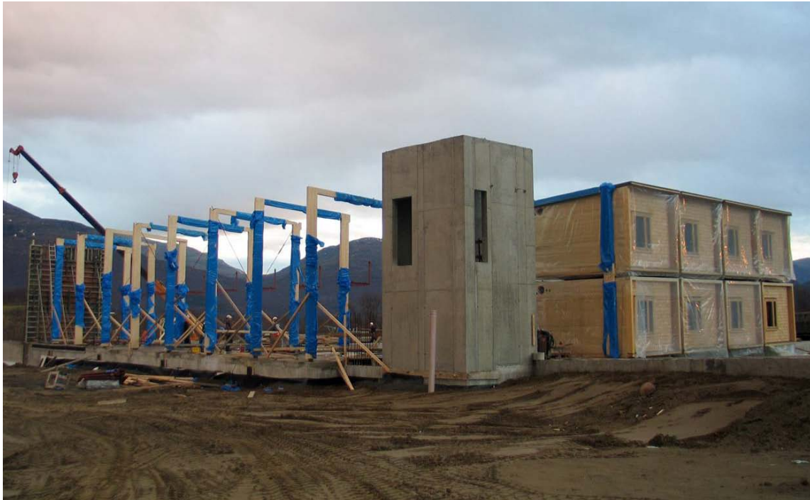
Figur 8. Volumseksjoner: Prefabrikkerte volumseksjoner heises på plass.
