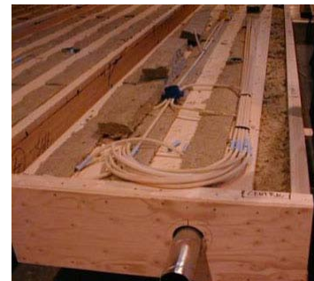
Figur 19. Montering av ventilation: Foto: Anders Gustavsson.
