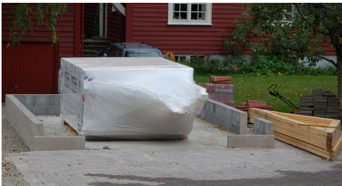
Figur 1. Precut : Ferdigkappede tredeler på byggeplass i emballasje.
