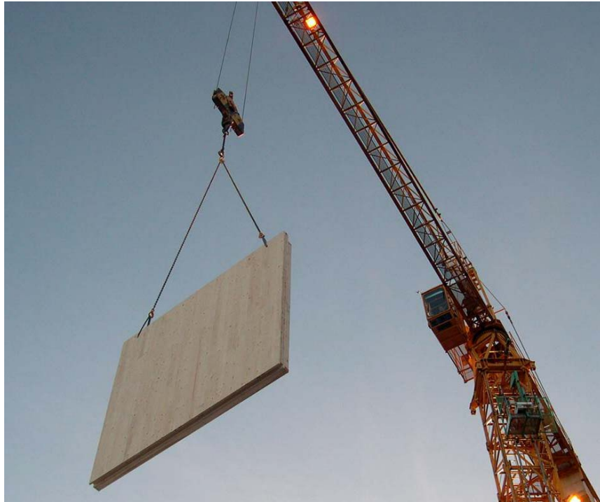
Figur 6. Elementbygg: Prefabrikkerte massivtrelementer som heises inn i bygget.
