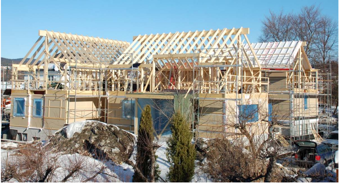
Figur 2. Precut: Plassbygging ved bruk av precut.
