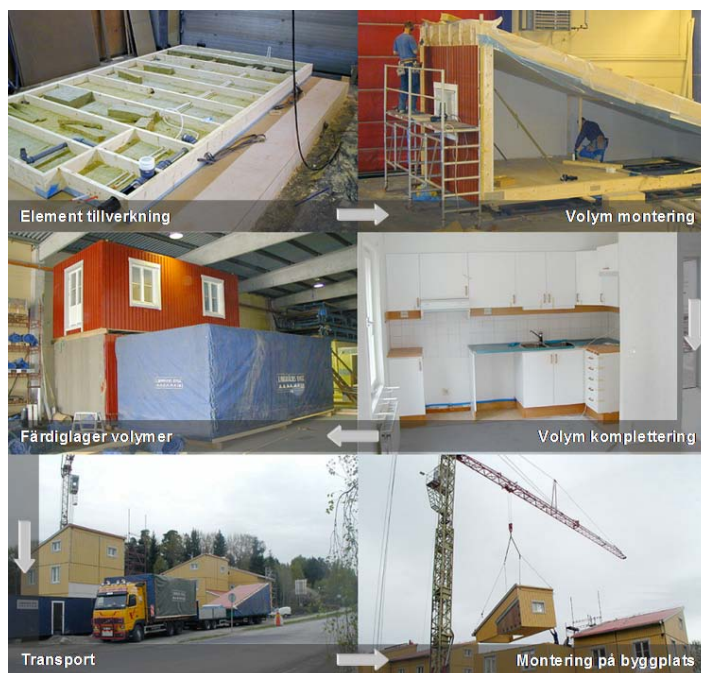
Figur 20. Tillverkning, färdigställande och montering av volymelement.
