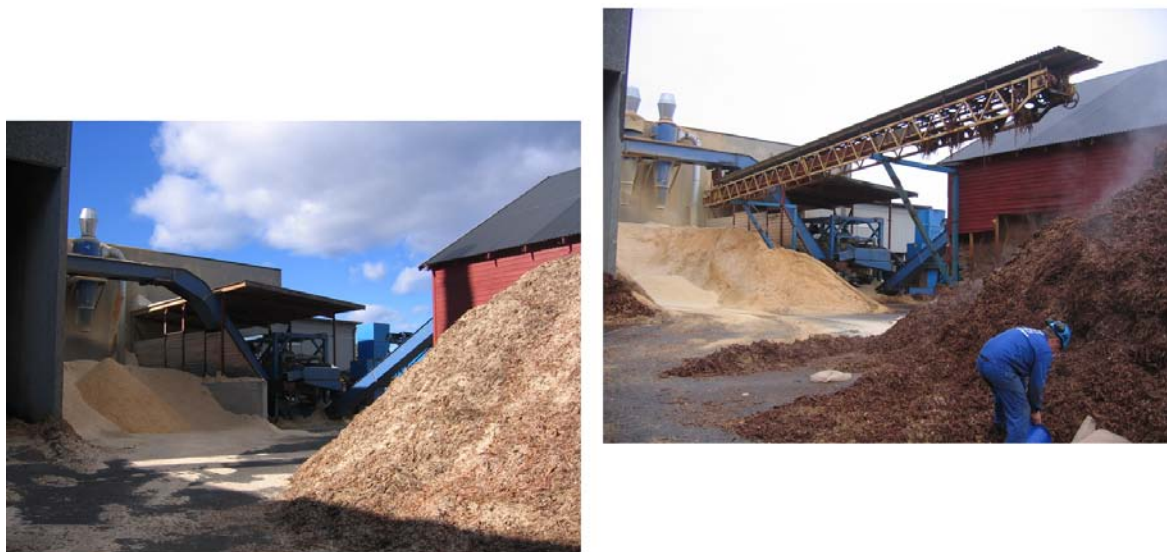
Figur 7. Bygging av transportør for bedre kontroll av fyrstoffet.
