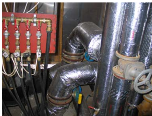
Figur 2. Isolering av rør med vannbåren varme gir store energibesparelser.
