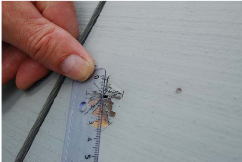
Figur 7. Registrering av avflassing på kvist på materialet.
