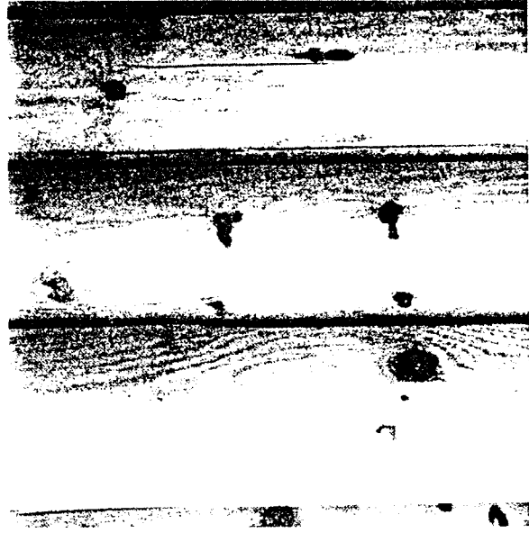
Figur 27. Kvaeflyting og overflatesprekk i stolper tørket i luft ved 80°C Figure 27. Bleeding of resin. Poles dried at 80°C
