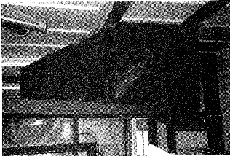
Kanaler i tak.
