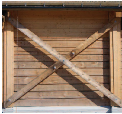
Vindavstiving, bjelker i kryss montert utvendig.
