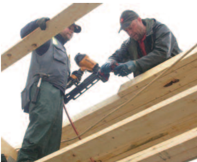
Pilotbygg i Rindal, montasje tak.
