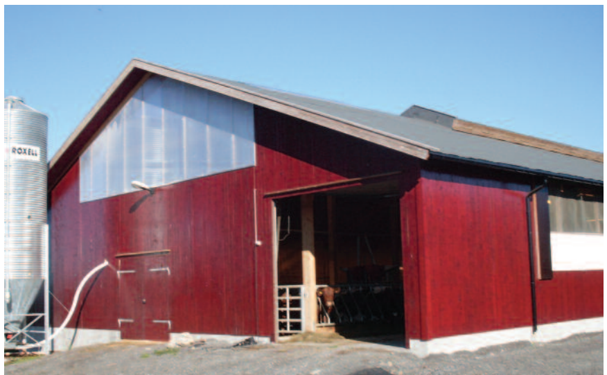
Pilotbygg på Toten i massivtre.
