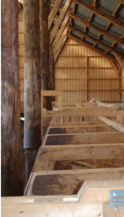
Pilotbygg i Grue, stolpekonstruksjon.
