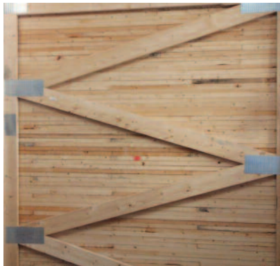
Vindavstiving, fagverk med spikerplater montert i tak.
