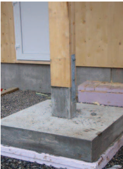
Fundamentering av søyle med beslag for forankring.
