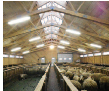
Sauefjøs med bæresystem av prefabrikkerte takstoler.
