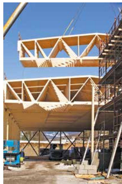
Ferdige takelementer heises på plass. (Pretre)
