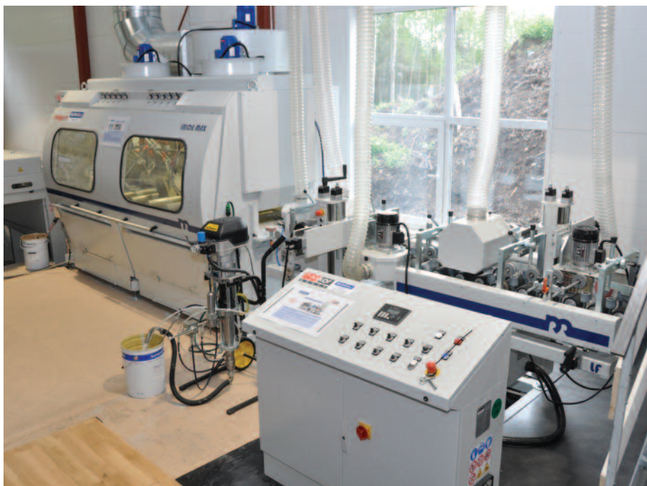
Børsting, påføring og tørking inn til venstre i 2. etg. i tørka.
