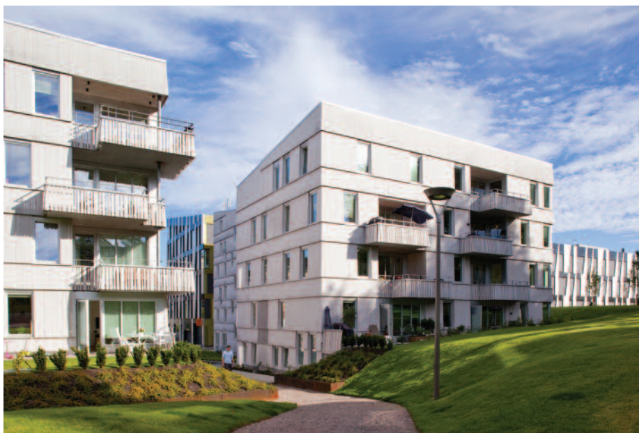
Malmfuru kledning behandlet med silikatmaling. Foto Marte Garmann. (Spikerverket, Nydalen, Oslo).
