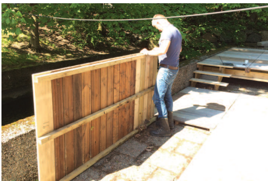
Bilde 2. Per Otto Flæte ved inspeksjon av terrassepålene for råte.
