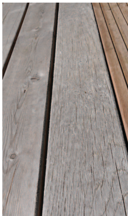
Bilde 5. Alle eikebordene i denne studien viste mange brede og dype, men relativt korte sprekker.
