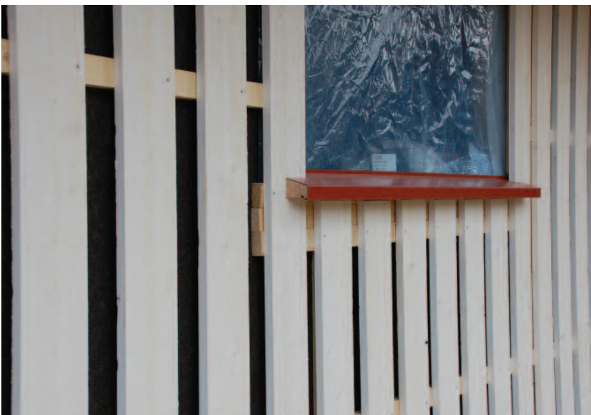
Fabrikkgrunnet kledning. Underligger er påført grunning på 3 sider.
