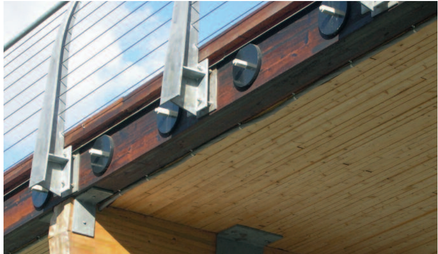
Tverrspent dekke hvor stag underlagskiver gir visuell effekt.
