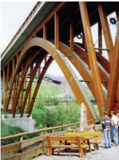
Europabrücke – buebro i Østerrike hvor dekket av betong ligger over limtrebuene.
