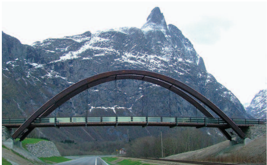
Ner Hole bru, Romsdalen. Buebro med dekket innfestet mellom buene.
