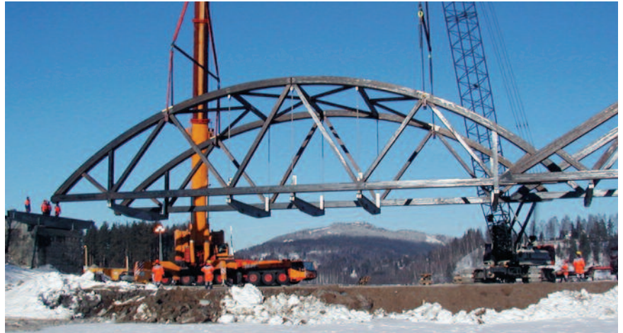
Fagverksbro på Flisa med rett undergurt og krum overgurt heises på plass.
