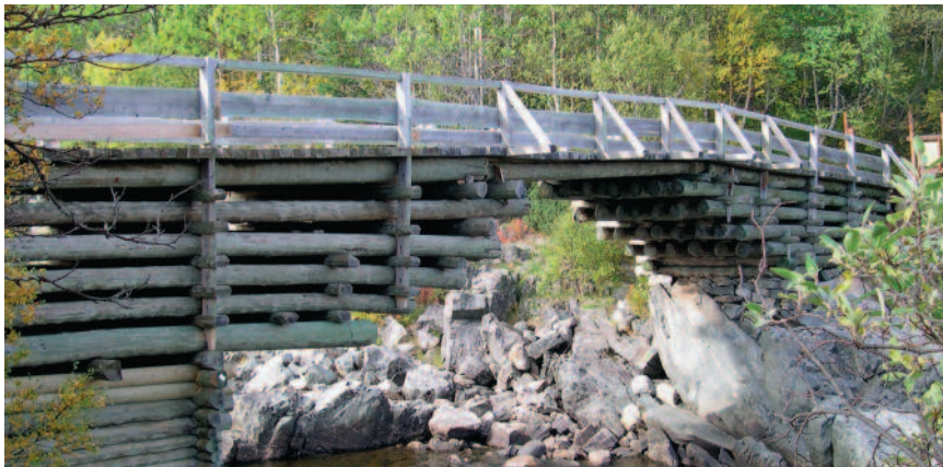
Fritt-frambyggbro. Tuftebro ved Ustaoset.
