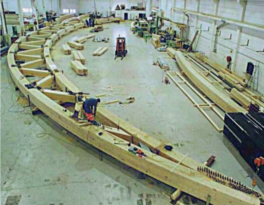
Prefabrikasjon av en fagverksbue.
