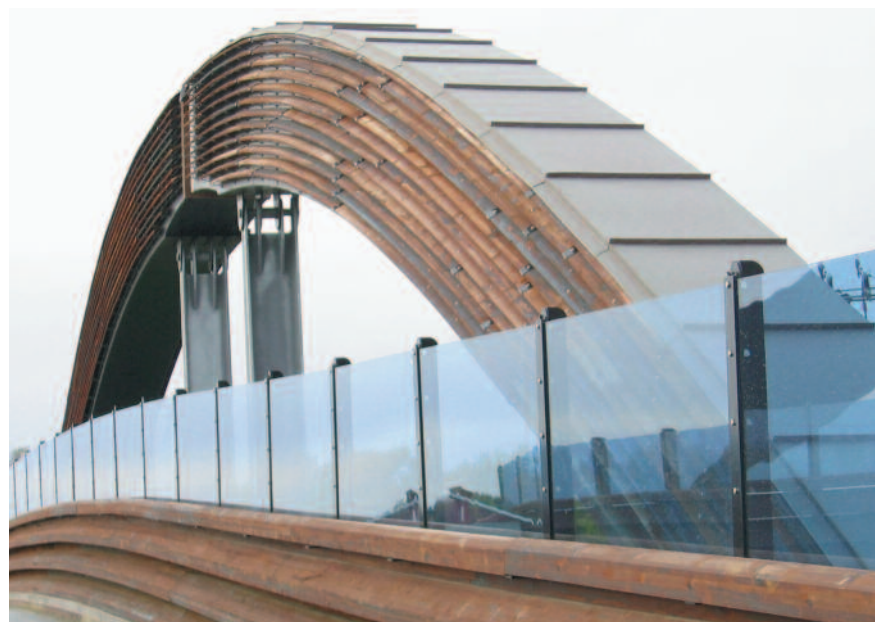
Konstruksjon beskyttet av trespiler og kobberbeslag.
